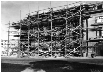
a. Intrarea studenților din strada Cometa, văzută din exterior (în dreapta schelelor) Fotografie din anul 1935
