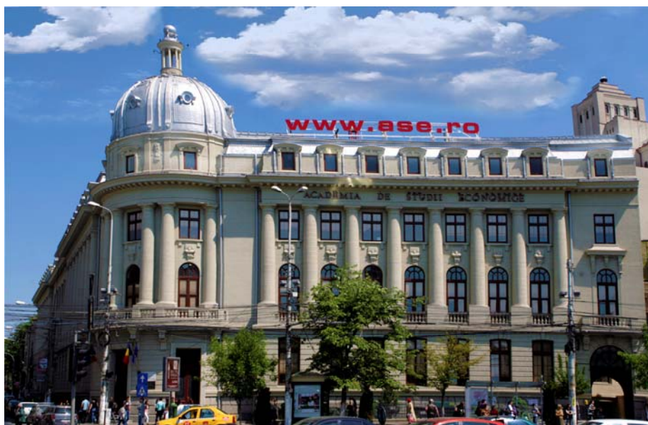
Figura 3.29 Palatul ASE după modernizare (ziua)
